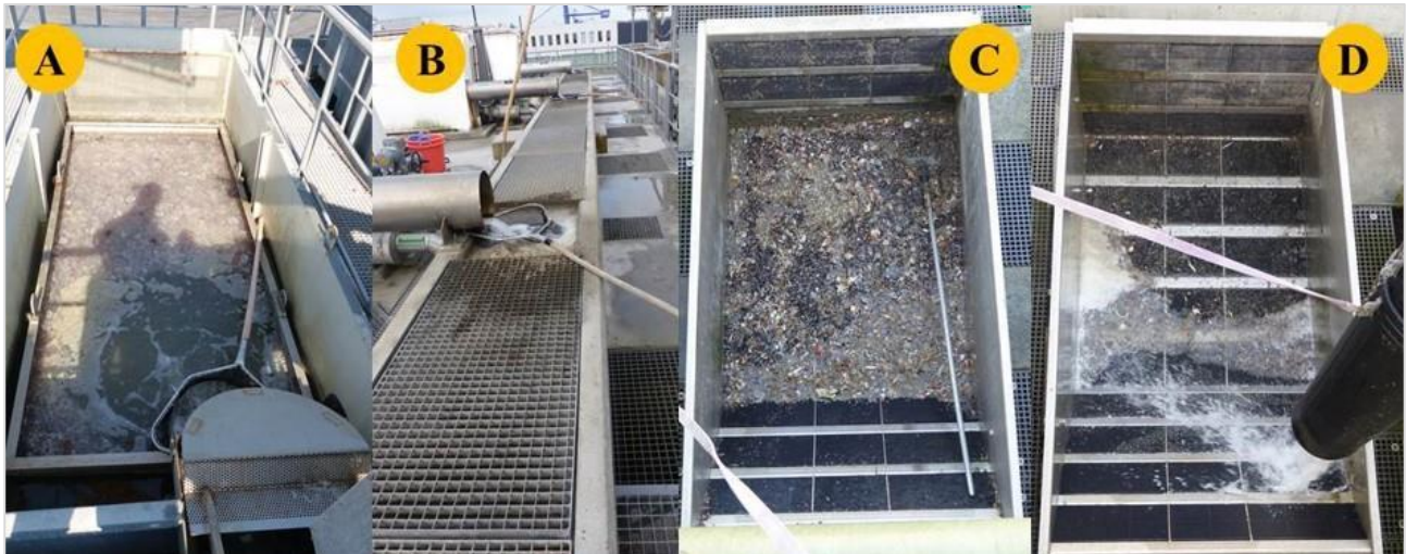
Abbildung 10: Positionen der Erfassung von Fischen und Makrozoobenthos (bis August 2017) Erfassung mit feinmaschigen Keschern am Überlauf in den kleinen Sammelcontainer (A), an den Überläufen der Siebbänder in die Zuleitungsrinne zum großen Sammelcontainer (B, Siebgut 1) und durch Leerung des Sammelcontainers für das Siebgut der zweiten Reinigungsstufe nach definiertem Zeitraum (C und D, Siebgut 2); Quelle: DÄNHARDT et al. (2016)
