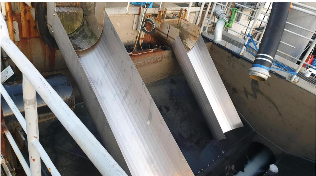
Abbildung 5: Verringerung der Fallhöhe durch Einbau von Rutschen im Fischsammelcontainer Quelle: ONYX POWER (2019)
