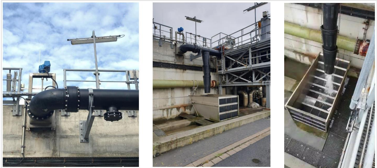
Abbildung 7: „Schillflansch“, um Schillmaterial bei Bedarf separat entsorgen zu können Quelle: ONYX POWER (2019)
